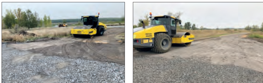
Рис. 4. Обустройство дороги с использованием сталеплавильных шлаков Fig. 4. Road construction using steelmaking slags
