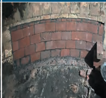
Секция газоходовентиллятора до 100 °С
