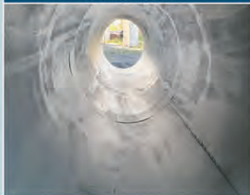
Секция газоходовентиллятора до 100 °С
