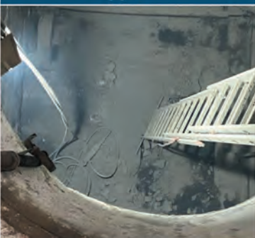
Емкости фосфорной кислоты, конц. 1-5%, t +60 °С
