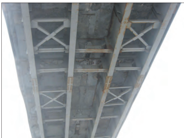
Рис. 4. Следы замкания поверхности бетона Fig. 4. Traces of concrete surface blocking
