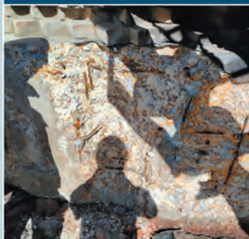
Емкости фосфорной кислоты, конц. 1-5%, t +60 °С
