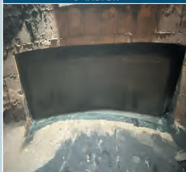
Секция газоходовентиллятора до 100 °С
